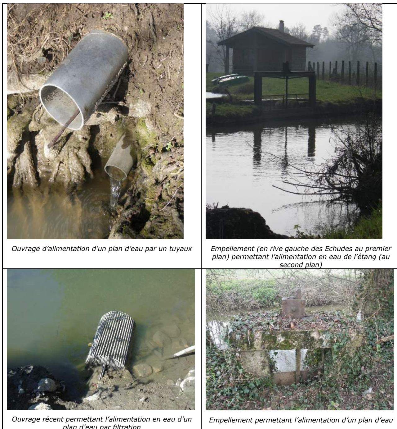
Figure 18 : Photographies des différents types d'ouvrages permettant l'alimentation en eau de plan d'eau (Source : SRTC 2015)
