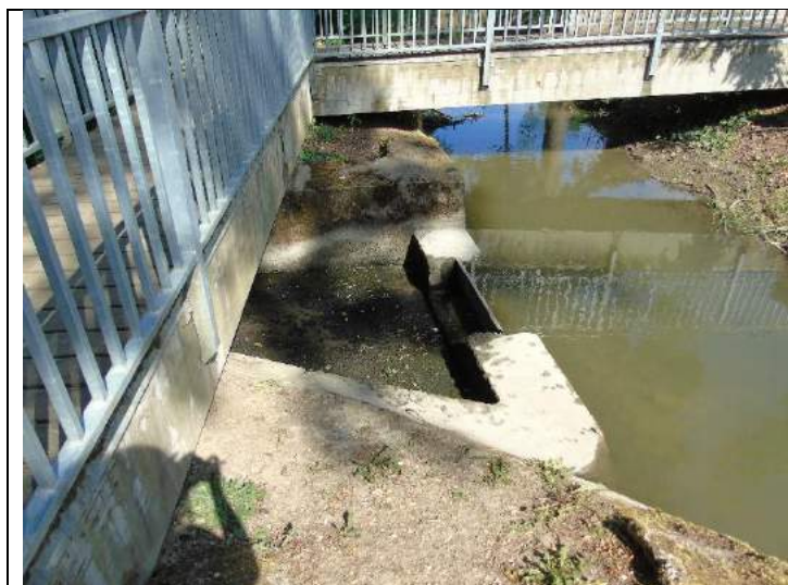
Empellement situé à l'amont du camping de Saint-Didier-sur-Chalaronne où l'eau passe par surverse (période de hautes eaux)
