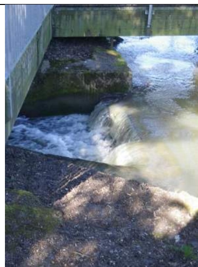
Empellement à l'amont du camping de Saint-Didier-sur-Chalaronne (période de basses eaux)
